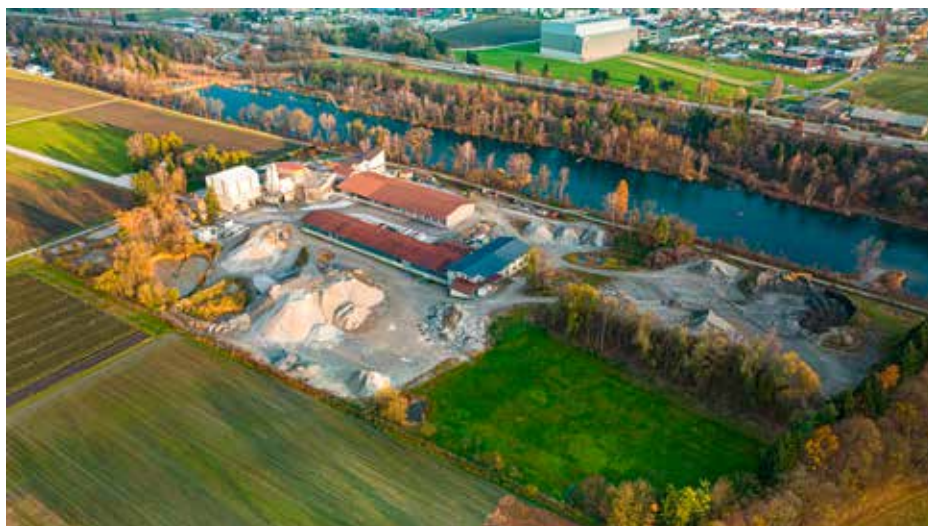
Werk Diepoldsau Büro und Disposition Werkstrasse 31 9444 Diepoldsau Tel. +41 71 737 91 61 Führt Sand, Kies und Spezialbeton
